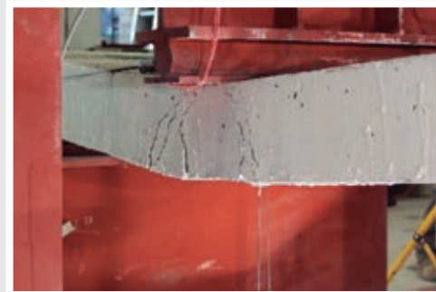
Estado Final Probeta Losa con Malla Electrosoldada ACMA® A630S
