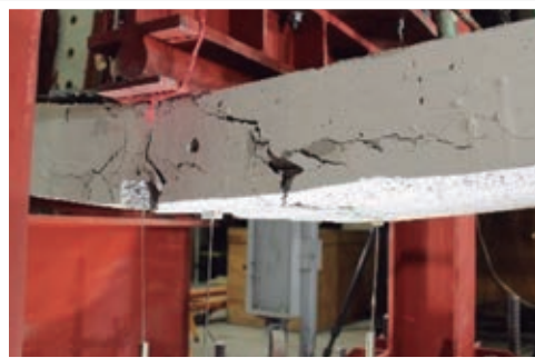
Estado Final Probeta Losa con Fierro Amarrado
